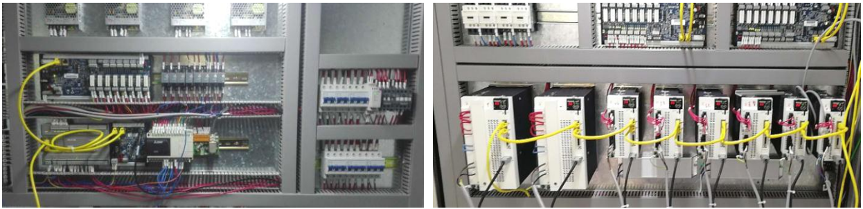
图 5-7 强电弱电分离示意图
