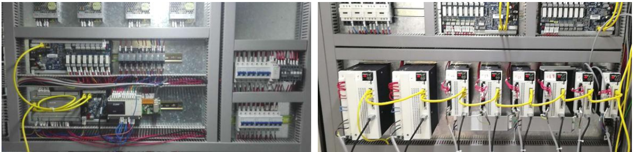
图 5-7 强电弱电分离示意图
