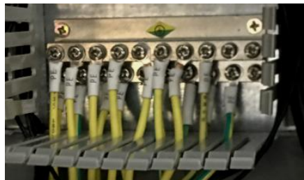
图 5-3 多点接地实物图
